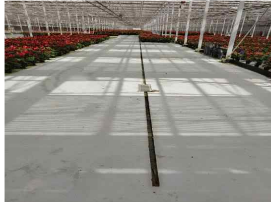
조석식 관개시설의 액상비료 공급·회수구
