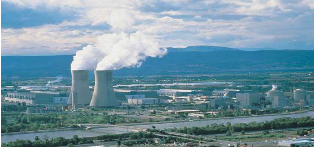
그림 1. 프랑스 크루아스 원자력 발전소의 전경
