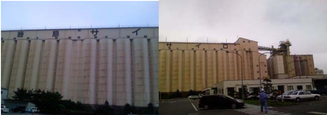
카시마항 최대 사일로 및 연결 배합사료 공장 전경(교와상교 곡물사 보유)
