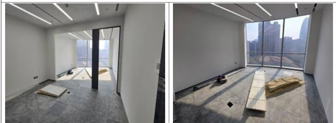
사무실 공사 현장
